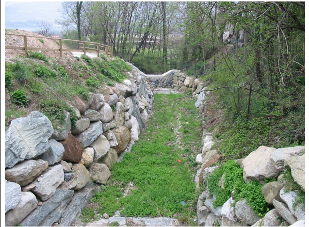
Opere di regimazione idraulica e di difesa spondale a valle del guado di Via per Baroncello.
