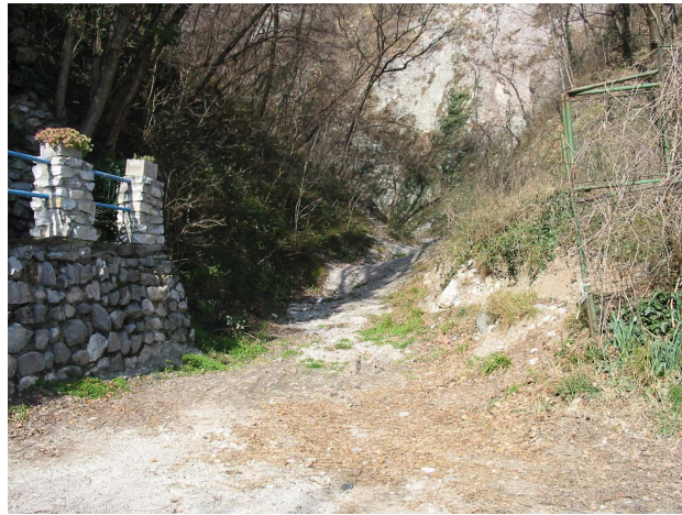
Alveo a monte del guado presente lungo la Via per Baroncello.
