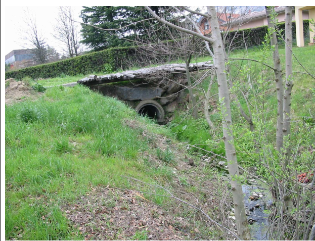
Tratto intubato a sud di Via San Miro.
